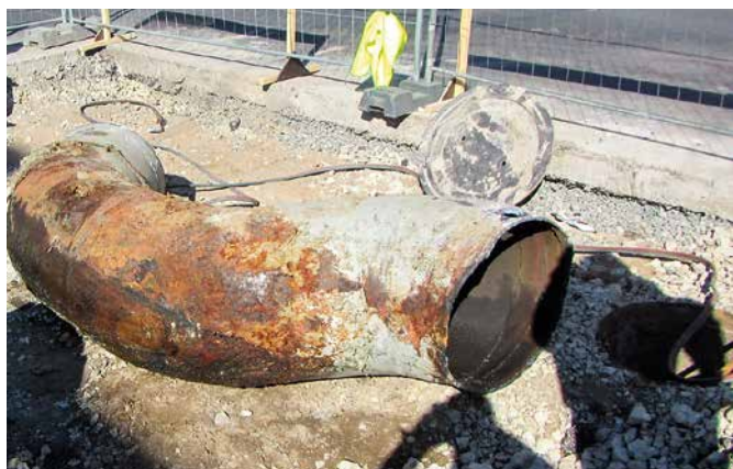
Siltumtīkli Brīvības ielā pirms rekonstrukcijas
