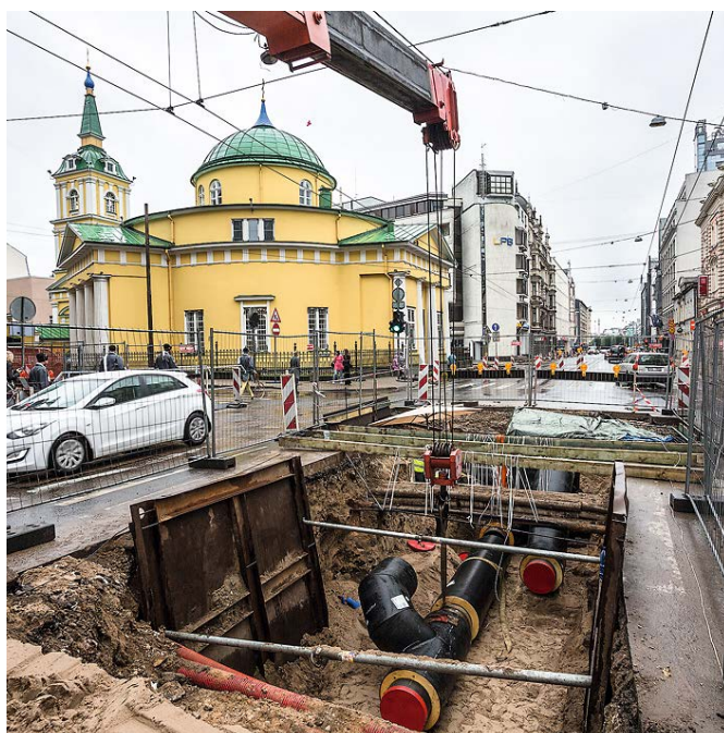
Siltumtīklu rekonstrukcijas darbi Brīvības ielā
