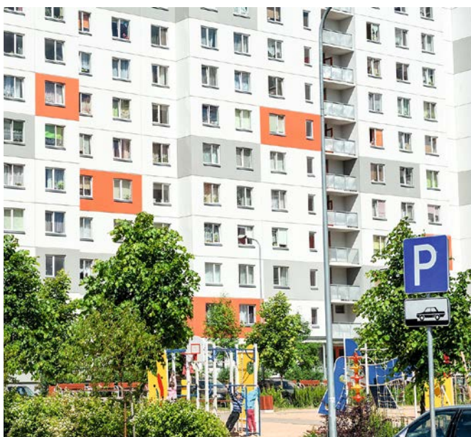
Ēka Ulbrokas ielā 13 korpus 5, kurā realizēts pilotprojekts ar alokatoriem
