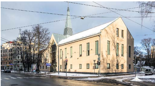
Jaunbūve – saietas nams Lāčplēša ielā 71
