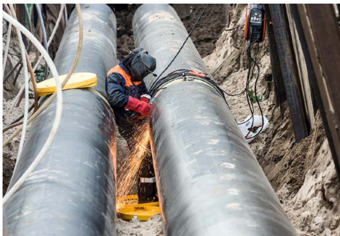
Siltumtīklu rekonstrukcijas un pārbūves darbi Ogres ielā
