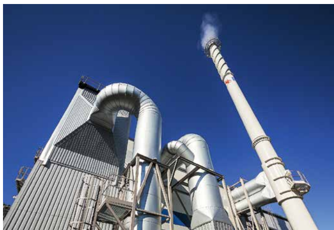
Siltumcentrāles "Zasulauks" biokurināmā katlu mājas fasāde.
