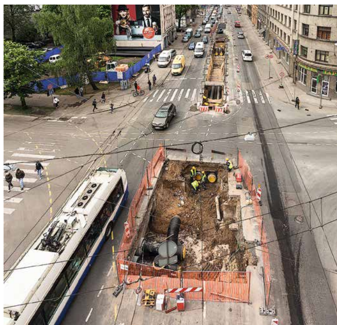
Siltumtīklu rekonstrukcija Brīvības ielā 2016. gadā.
