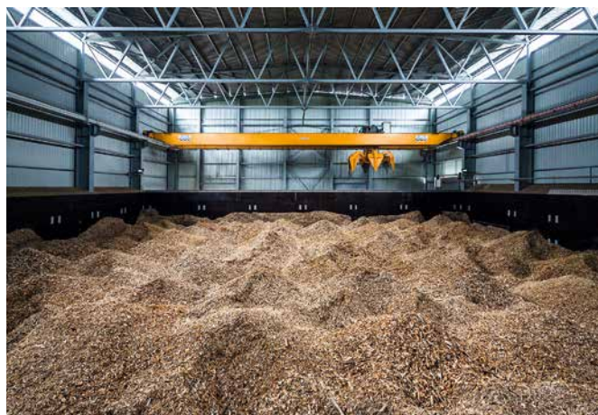
Siltumcentrāles "Zasulauks" kurināmā koksnes šķeldas noliktava. Kurināmā pārvietošanu veic automatizēts greiferis.
