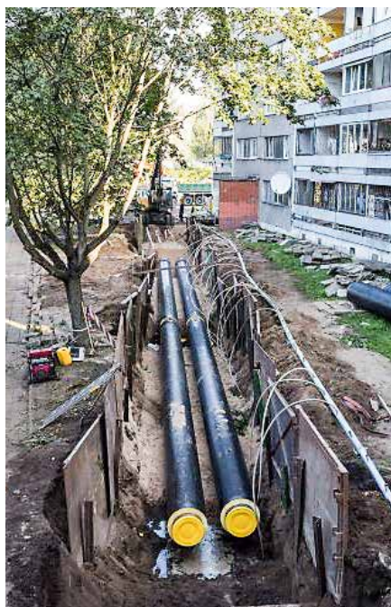
Siltumtīklu pārbūve Ogres ielā
