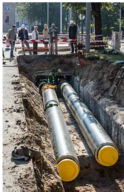
Siltumtīklu pārbūve A.Čaka ielā
