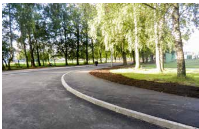
Labiekārtošanas darbi pēc remontdarbiem Dammes ielā
