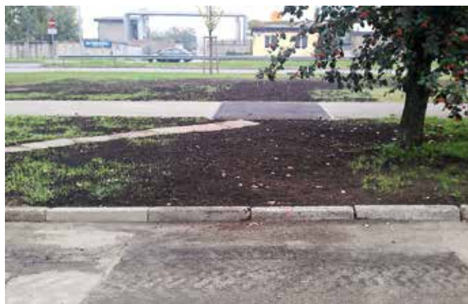
Labiekārtošanas darbi pēc remontdarbiem Krustpils ielā
