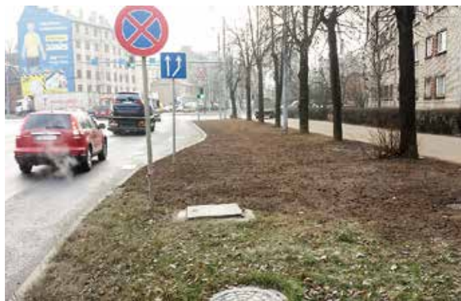
Zaļās zonas atjaunošana pēc remontdarbiem A.Čaka ielā
