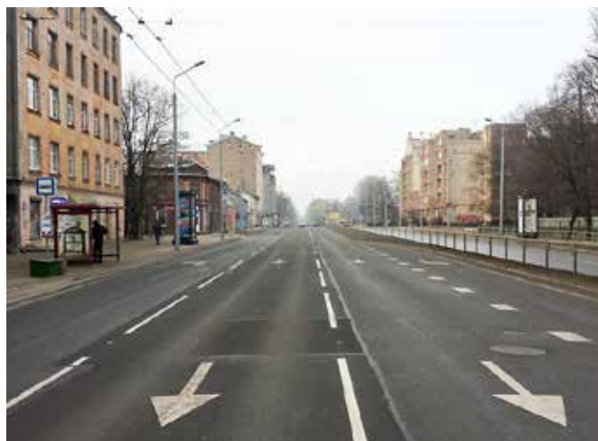
Asfalta seguma atjaunošana pēc remontdarbiem A.Čaka ielā
