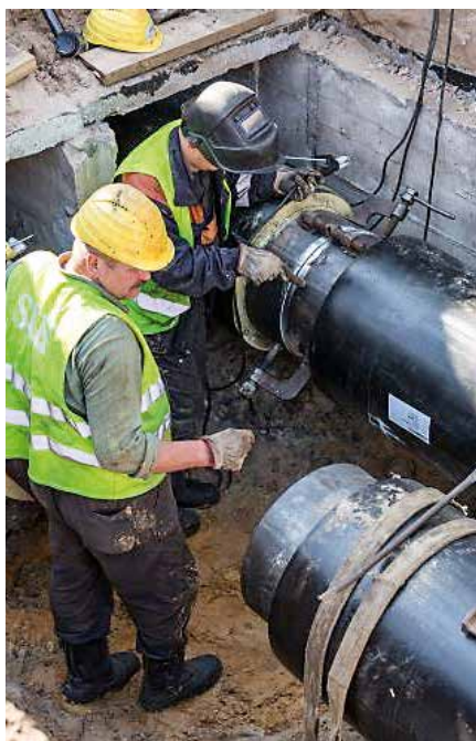
Siltumtīklu pārbūve A.Čaka ielā
