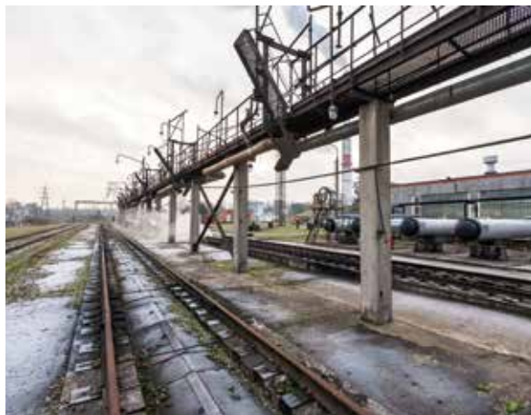
Siltumcentrālēs "Imanta" mazuta saimniecības mazuta pieņemšanas mezgls un dzelzceļa pievadceļš. Šajā mazuta saimniecībā tika uzglabāts vislielākais mazuta daudzums uzņēmumā līdz 10 000 tonnām. Tālāka mazuta saimniecības izmantošana netiek plānota.
