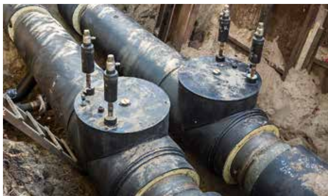
Rūpnieciski izolēto mezglu uzstādīšana
