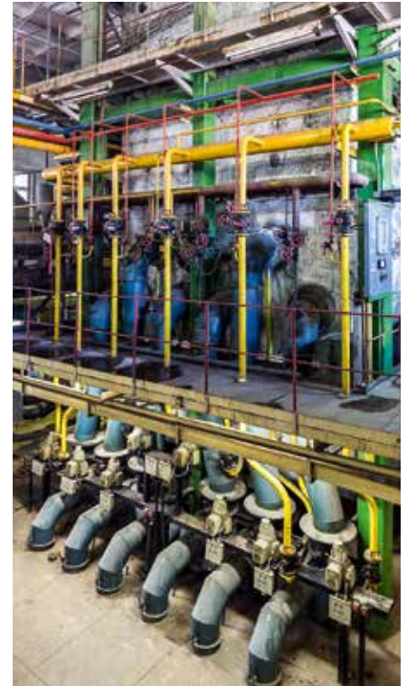
Siltumcentrāles "Zasulauks" gāzes katlu zāles cauruļvadu mezgls. Protams, vecajos "dzelžos" ir savs skaistums un siltumcentrāles "Zasulauks" dabasgāzes katli ir labs pagājušā gadsimta industriālā dizaina paraugs, kura paraugus ir vērts saglabāt nākotnei.
