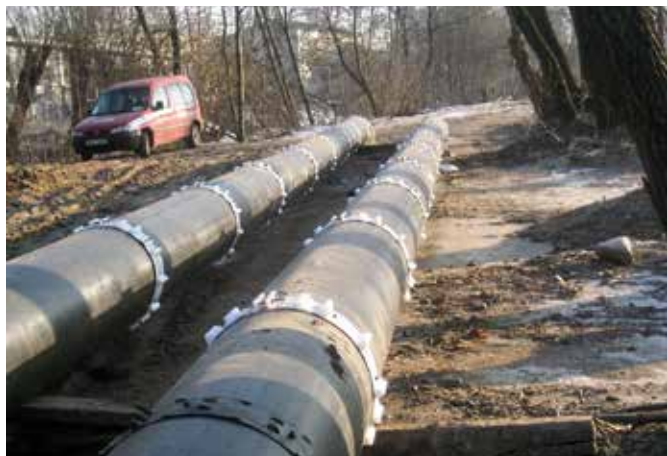
Kreisā krasta saistvada izbūve no Akmeņu ielas līdz Vienības gatvei (ar dzelzceļa pārvadu)
