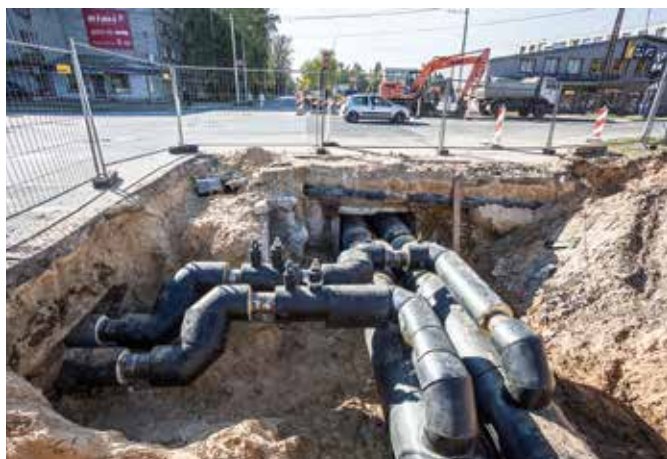
Siltumtīklu pārbūve Prūšu ielā
