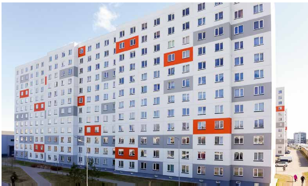
SIA "Rīgas pilsētņēmums" ēka Ulbroka ielā 13 k.5
