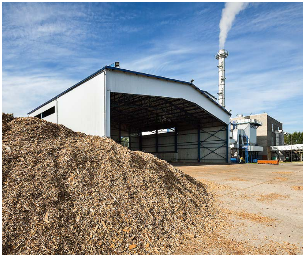
SC „Ziepniekkalns” biokurināmā koģenerācijas stacija
