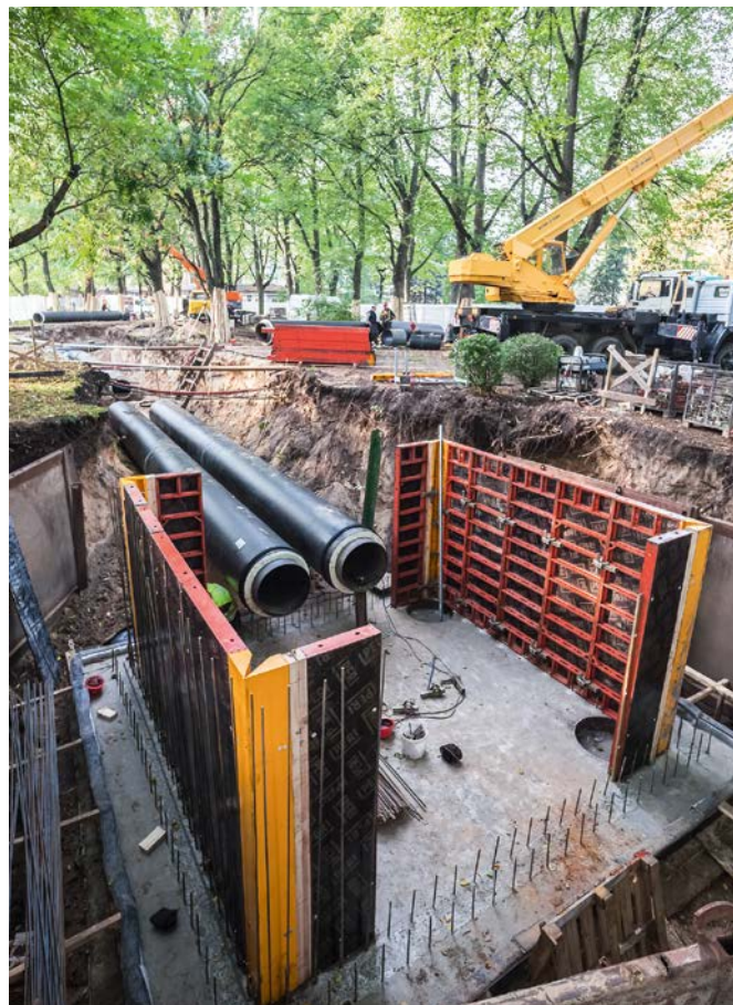
Siltumtīklu maģistrāles M-8 rekonstrukcija
