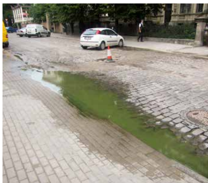
Hidrauliskās pārbaudes laikā siltumtīklu bojājuma vietā iespējama zaļganās krāsas ūdens noplūde.
