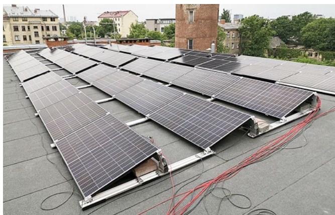
Saules paneļu montāža Cēsu ielā 3A uz ēkas jumta
