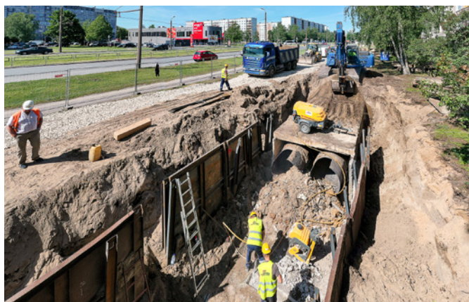
Siltumtīklu pārbūve Dzelzavas ielā
