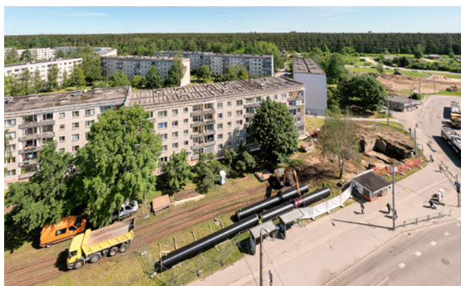
Siltumtīklu pārbūve Dzelzavas ielā
