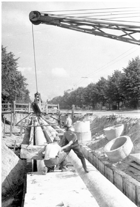
8924N Siltumtrases būvniecība Ļeņina ielā (Brīvības iela). Rīga, 20.09.1957. Avots: Valsts Nacionālais Arhīvs
