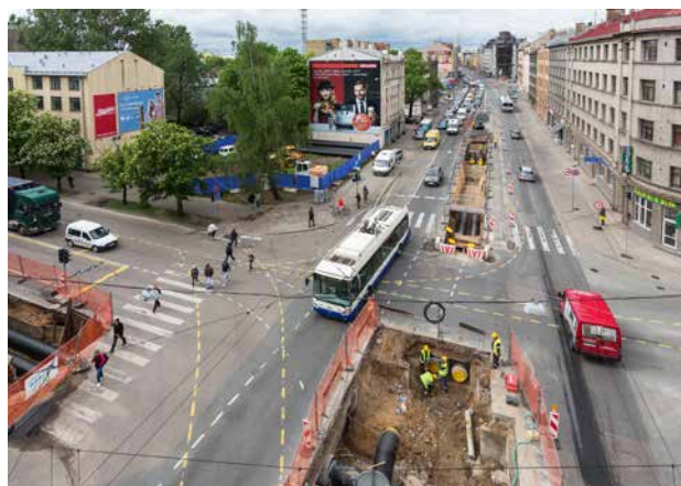
Siltumtrases Brīvības ielā rekonstrukcija 2017. gadā.
