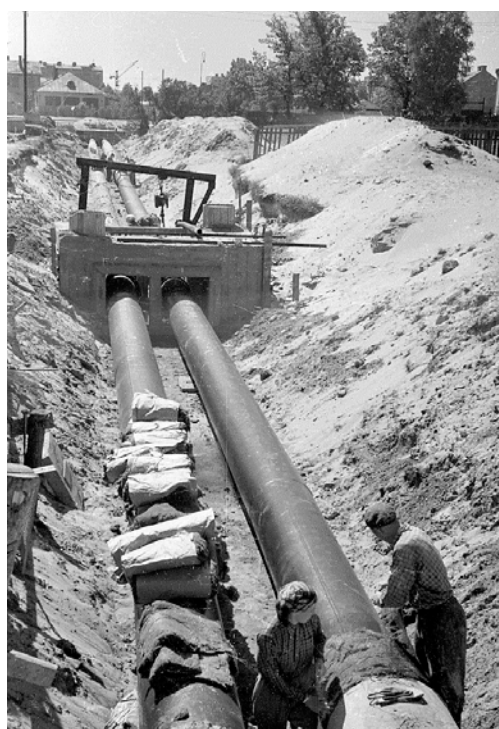
8778N Rīgas TEC celtnieki liek caurules galvenajā TEC siltummezgla maģistrāles iecirknī Ļeņina ielā (Brīvības iela). Rīga, 04.07.1957. Avots: Valsts Nacionālais Arhīvs
