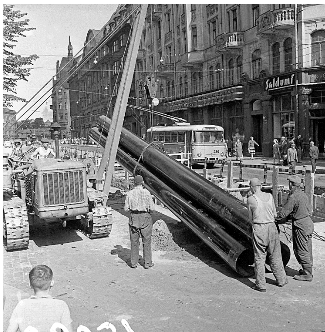
3129N-1 Siltumtrases būvniecība Ļeņina ielā (Brīvības iela). Rīga, 09.08.1962. Avots: Valsts Nacionālais Arhīvs
