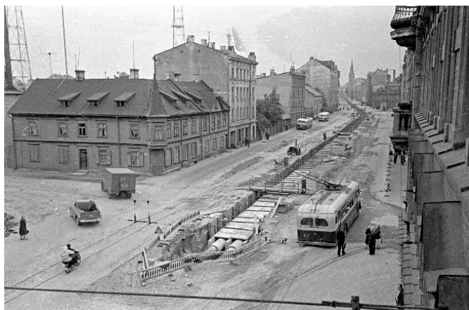
5699N Siltumtrases būvniecība Ļeņina ielā (Brīvības iela), netālu no Gaisa tilta. Rīga, 00.10.1958. K.Auziņš. Avots: Valsts Nacionālais Arhīvs
