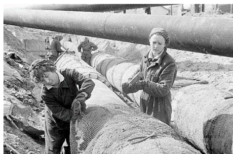
8912N Jaunās strādnieces Ļina Vasilova (no kreisās puses) un Klaudija Petrova izolē caurules galvenajā siltumtrases maģistrālē. Rīga, 13.09.1957. Avots: Valsts Nacionālais Arhīvs
