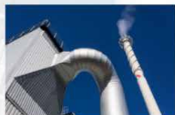
Degšanas gaisa mitrināšanas sistēma "Optinox" samazina NOx izmešus par 60%
