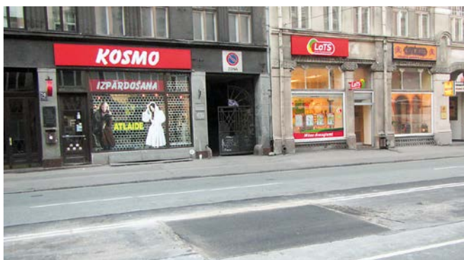
3) atjaunots asfalta segums
