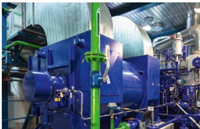
Tvaika turboģenerators
